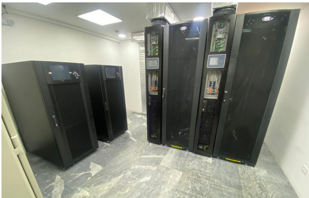
Avance instalación infraestructura en espejo data Center Edificio Nuevo del Congreso
