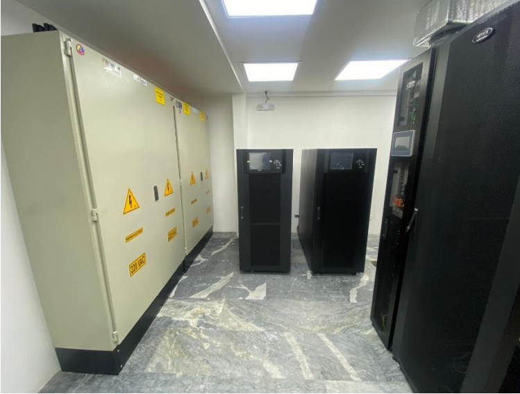
Servicio Eléctrico Redundante En el data center espejo – Edificio Nuevo del Congreso
