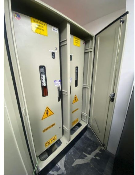
Servicio Eléctrico Redundante En el data center espejo – Edificio Nuevo del Congreso
